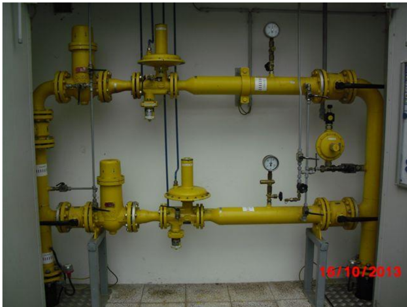
Abbildung 5: Zweischieenige Regelung gemäß G 491 für max. 1.000 m 3 /h von MOP 16 auf MOP 1
