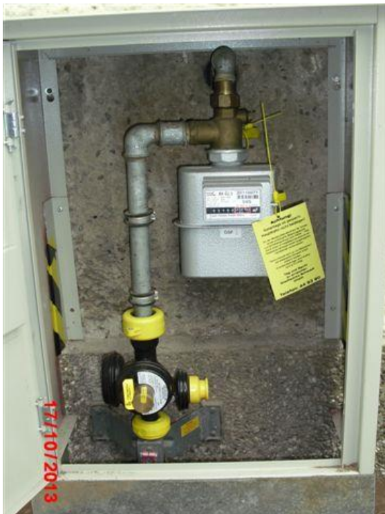
Abbildung 2: Anschlusschrank außen
