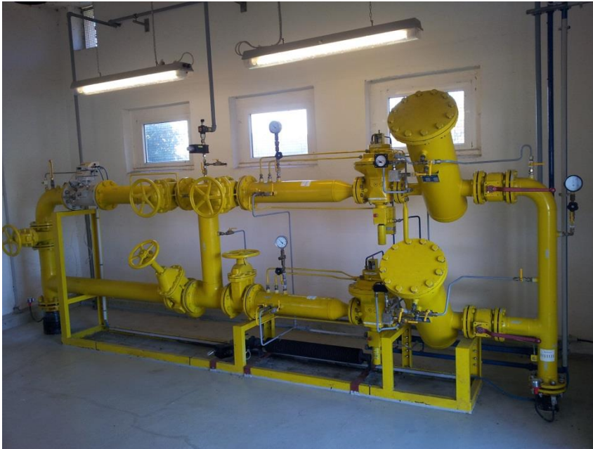
Abbildung 6: Regelung gemäß G 491 für max. 2.500 m 3 /h von MOP 16 auf MOP 4
