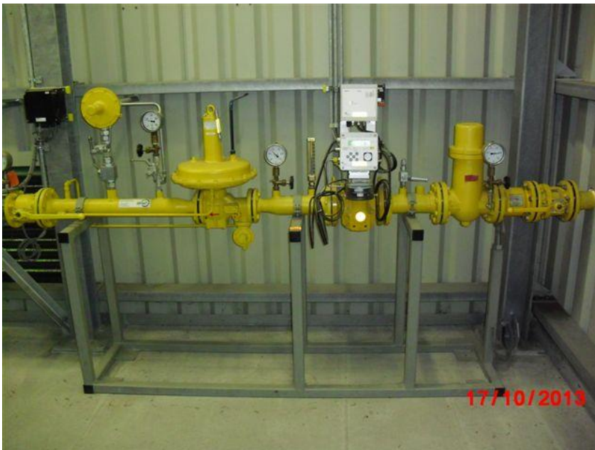
Abbildung 7: Regelung gemäß G 491 für max. 250 m 3 /h von MOP 1 auf MOP 0.1
