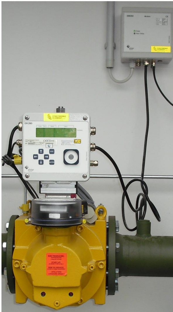
Abbildung 8: Drehkolbengaszähler mit Mengenumwerter und Kommunikationseinheit
